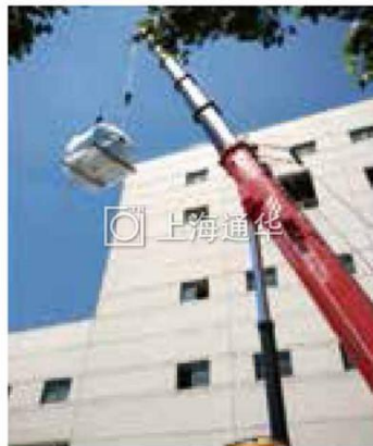
新设备起吊安装
