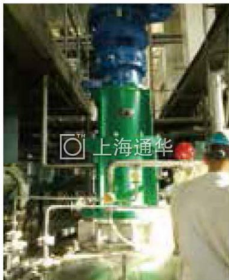
设备停车后内部勘测
