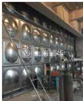
水箱现场制作
