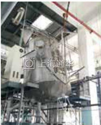
12吨旧设备从厂房内拆除
