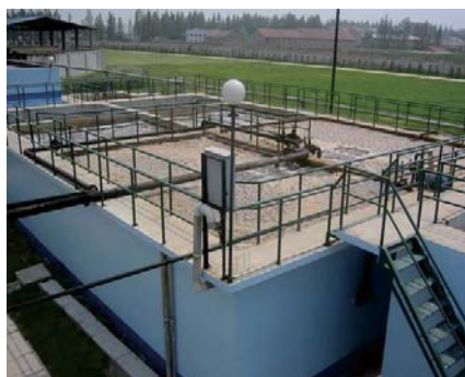
山海关含油废水工程
