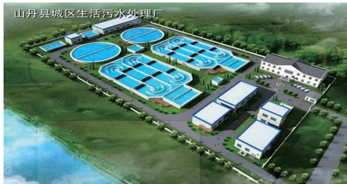
山丹县城区生活污水处理厂 ( 1.5 \times 10^4 \text{ m}^3/\text{d} DE型氧化沟工艺)
