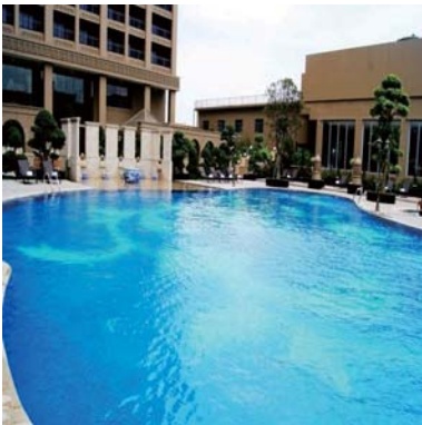
世贸中心游泳池工程
