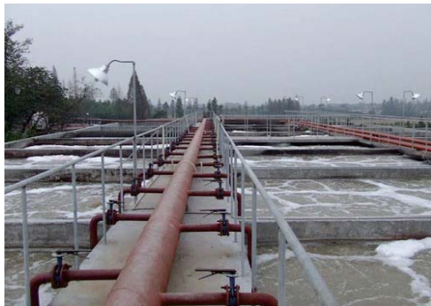
泰山石化污水处理工程
