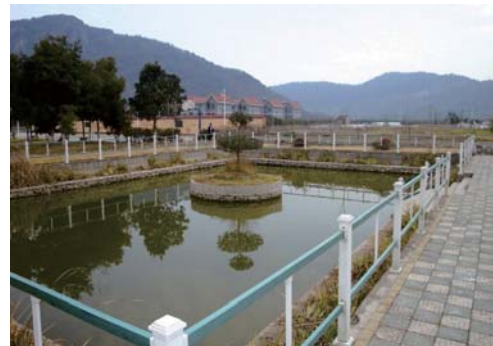
天津污水处理工程
