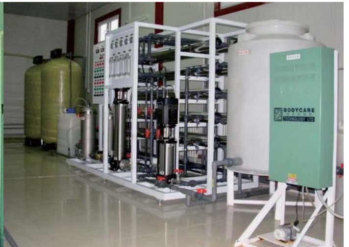
制药厂纯水水处理工程 (4T/H)
