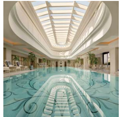
国际大厦游泳池工程
