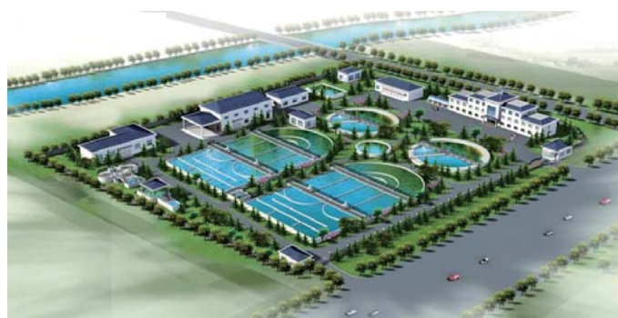
重庆市南川污水处理厂 ( 4 \times 10^4 \text{ m}^3/\text{d} ORBAL氧化沟工艺)
