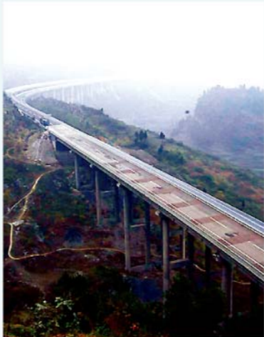
贵州·崇道高速公路
