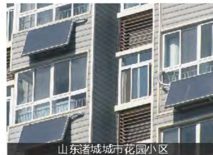
山东诸城城市花园小区
