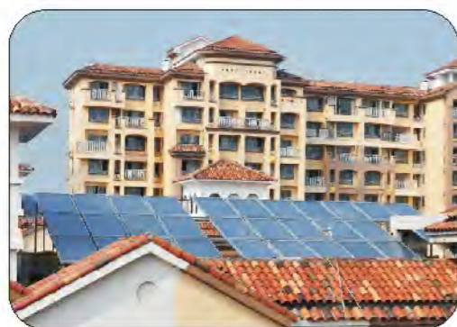
屋顶安装位置
